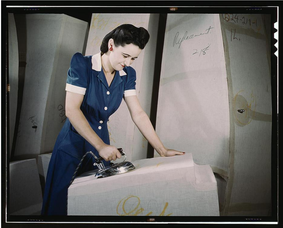
Figura 3: Trabalhadora utilizando o ferro de passar durante a fabricação de tanques auto-selantes de gás da Goodyear Ohio, Estados Unidos – Dezembro de 1941. (Alfred T. Palmer/OWI/Library of Congress). Fonte: < http://veja.abril.com.br/blog/sobre-imagens/mulheres/a-mao-de-obra-feminina/ >. Acesso em: 14 de novembro de 2013.
